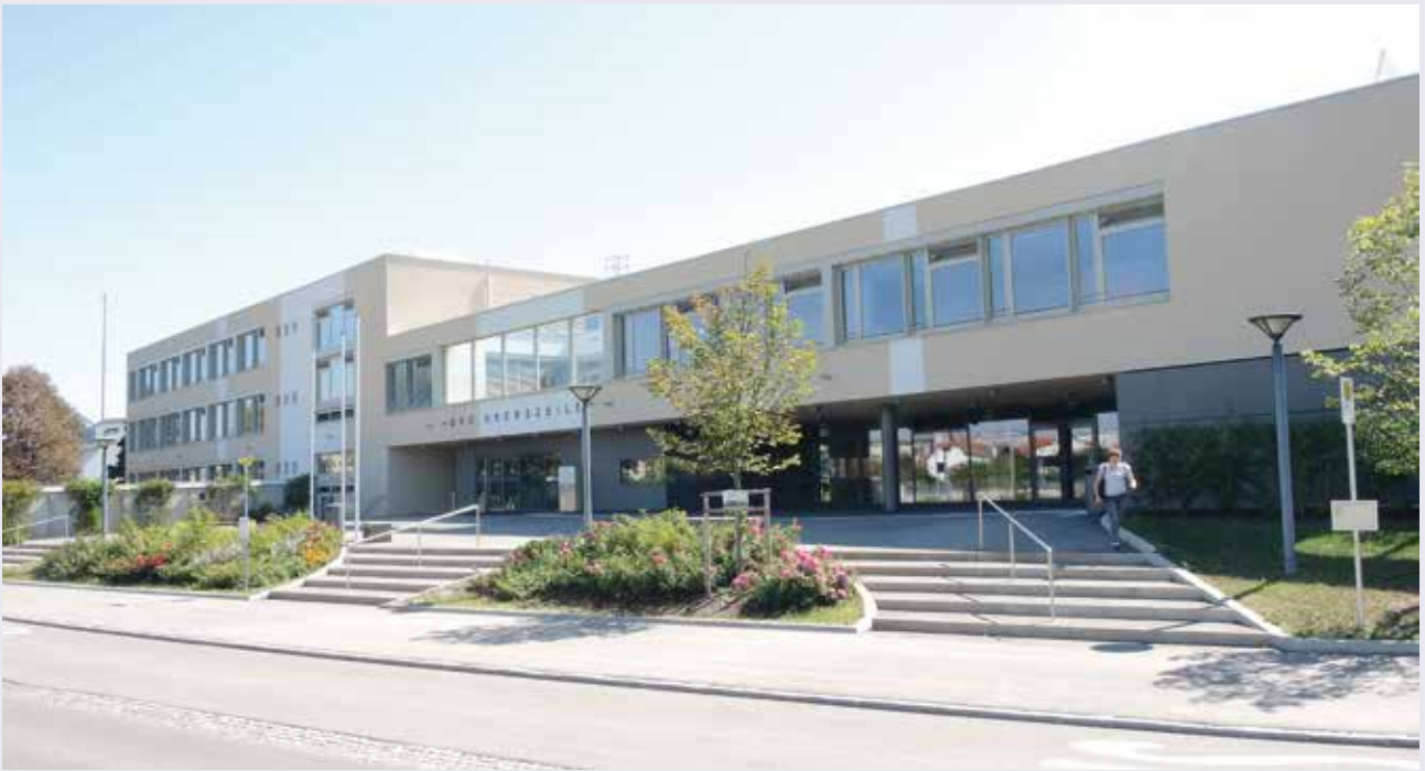
Bundesrealgymnasium Kremszeile, Krems, Architektur: trafo kirchmayr & nöbauer GesbR, Wien
